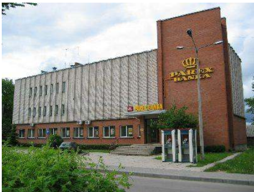
36.attēls. Latgales iela 103. Raksturīga 70. gadu ēka – telefonu centrāle un biroji, kur kombinēti dzelzsbetona paneļi un sarkanais ķieģelis. Ēka novietota ar lielu atkāpi no sarkanajām līnijām.
