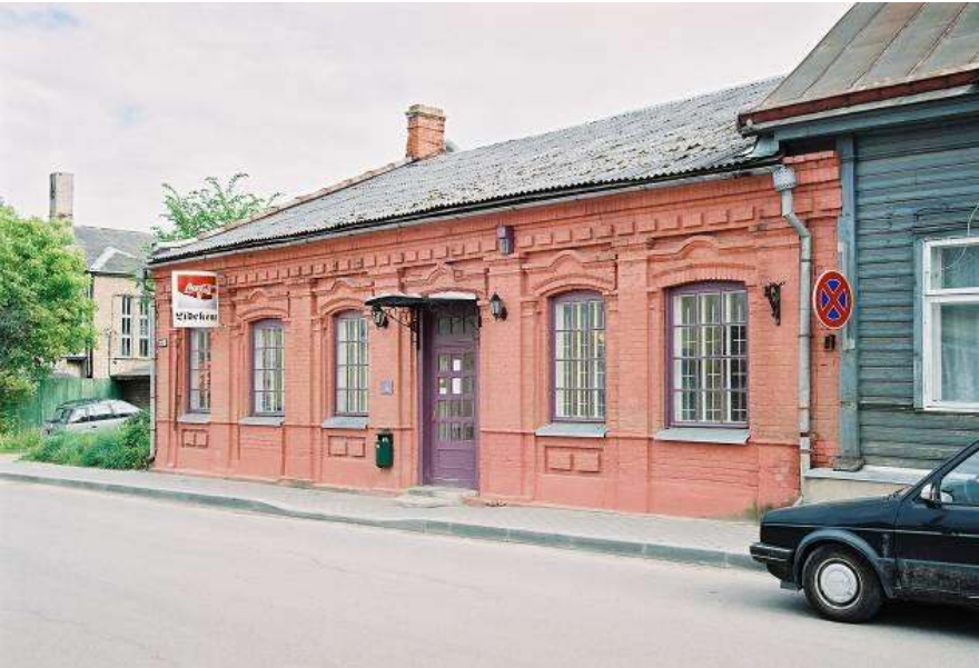
34.attēls. Latgales iela. Latgales reģionam tipiska grezna sarkano ķieģeļu ēka, 19. / 20. gadsimta mija.
