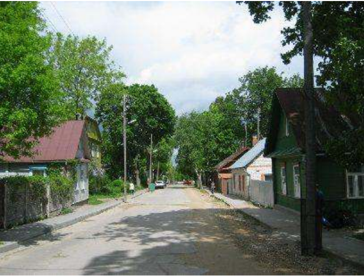
42.attēls. Stacijas iela – raksturīgā ielas fronte, kur perimetrālo apbūvi veido brīvstāvošas ēkas un tām cieši blakus piebūvēti blīvi žogi.
