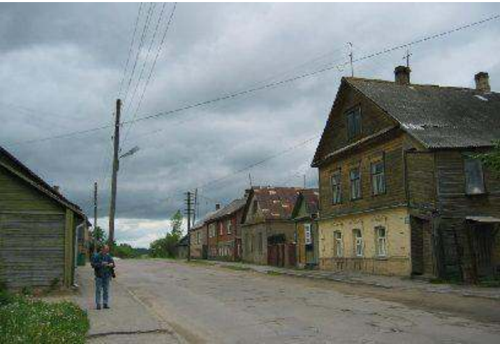
43.attēls. Tālavijas iela raksturīga ar to, ka daudzām ēkām izteikti augsti (līdz pat 2,3 / 2,5 metriem no zemes) mūra virspamati (cokola stāvs). Risinājuma izvēli iespējams noteicis ēku izvietojums zemā, dažkārt applūstošā vietā.
